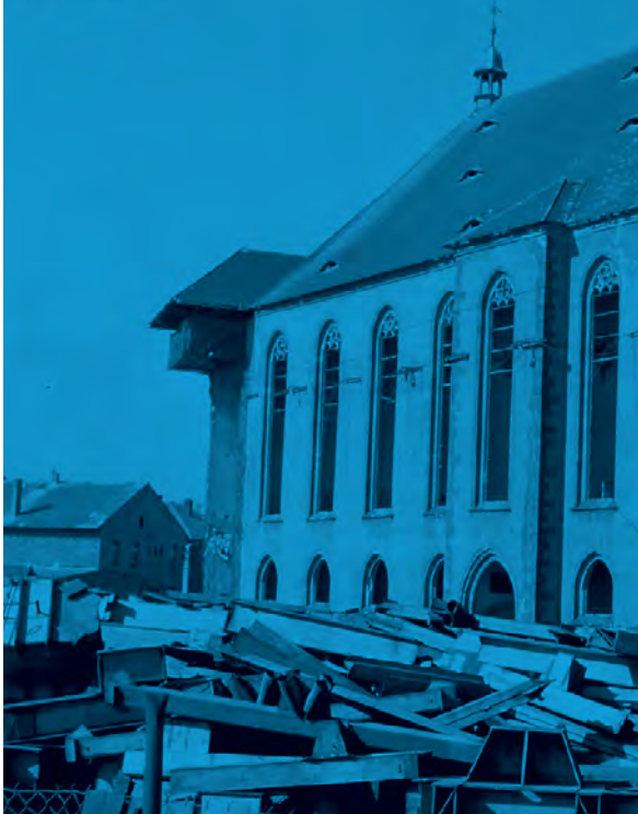
Kostel Nanebevzetí Panny Marie po přesunu, bezprostřední poškození stabilizační zdiva a demontáží ocelových konstrukcí.
